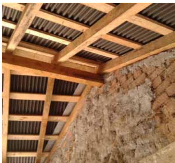
Obras em execução
