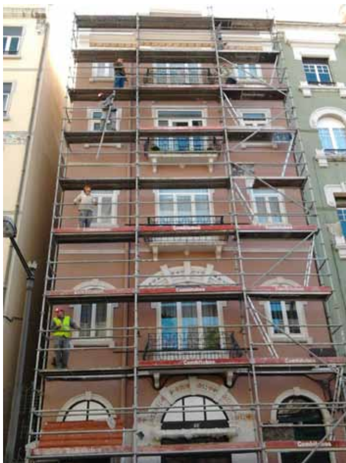
Obras em execução
